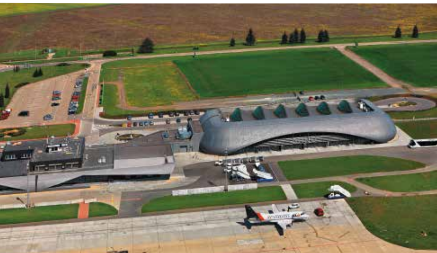
Stavba roku 2007 – odbavovací hala letiště v Brně-Tuřanech
